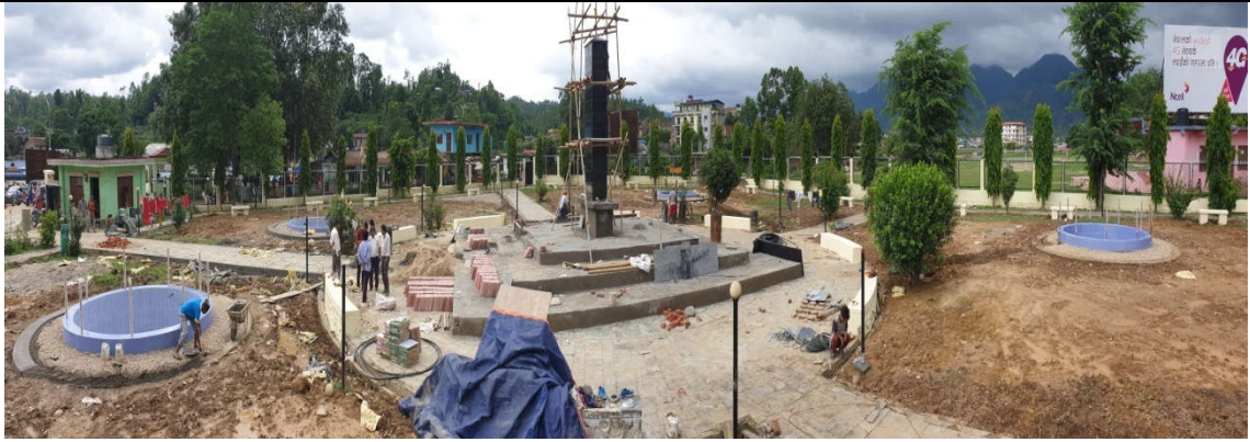
कमलामाई न.पा. मा निर्माण भइरहेको उद्यान
